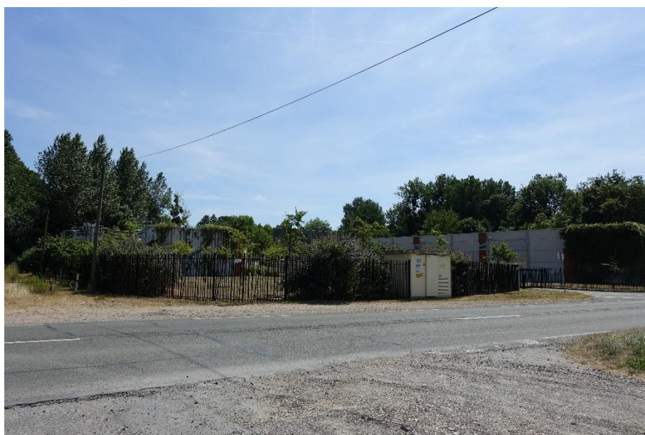
Station d'épuration de Gasny
